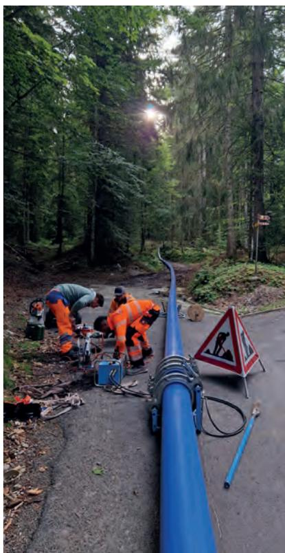
*Il n'a pas été nécessaire d'enlever la gaine de protection avant la soudure, ce qui garantit un traitement rapide et la sécurité lors de la pose.*
