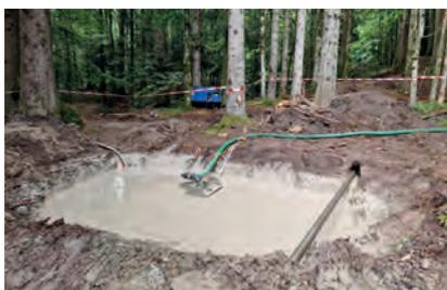
*Dans la fosse intermédiaire, la bentonite (minéral argileux) provenant du rinçage était récupérée et transportée régulièrement au moyen d'un camion vers une installation de recyclage mobile située sur place. Cela a permis de réduire les coûts et l'aspect écologique a également été pris en compte.*
