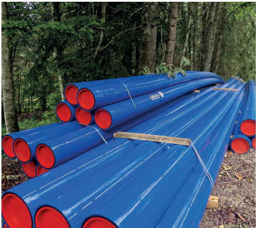
*Pour la conduite d'eau potable de 360 mètres dans un terrain fortement boisé, on a utilisé le tuyau de refoulement armé Jansen Wavin TS à trois couches. Le tube est fabriqué en Finathen N 8000 du groupe de matériaux PE 100 RC, très résistant aux charges et aux fissures de tension.*
