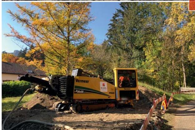
en ouvrant une tranchée, une solution privilégiée pour diminuer les risques en présence de multiples conduites (gaz, fibre optiques, conduites d'eau,...). Les nouveaux tuyaux suivent donc le tracé existant, avec des perturbations moindres. Ce procédé est amené à se développer grandement à l'heure de la densification urbaine et du développement durable.
